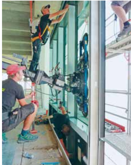
Rund 30 Elemente konnten pro Arbeitstag eingesetzt werden. Une trentaine d'éléments ont été placés quotidiennement.
