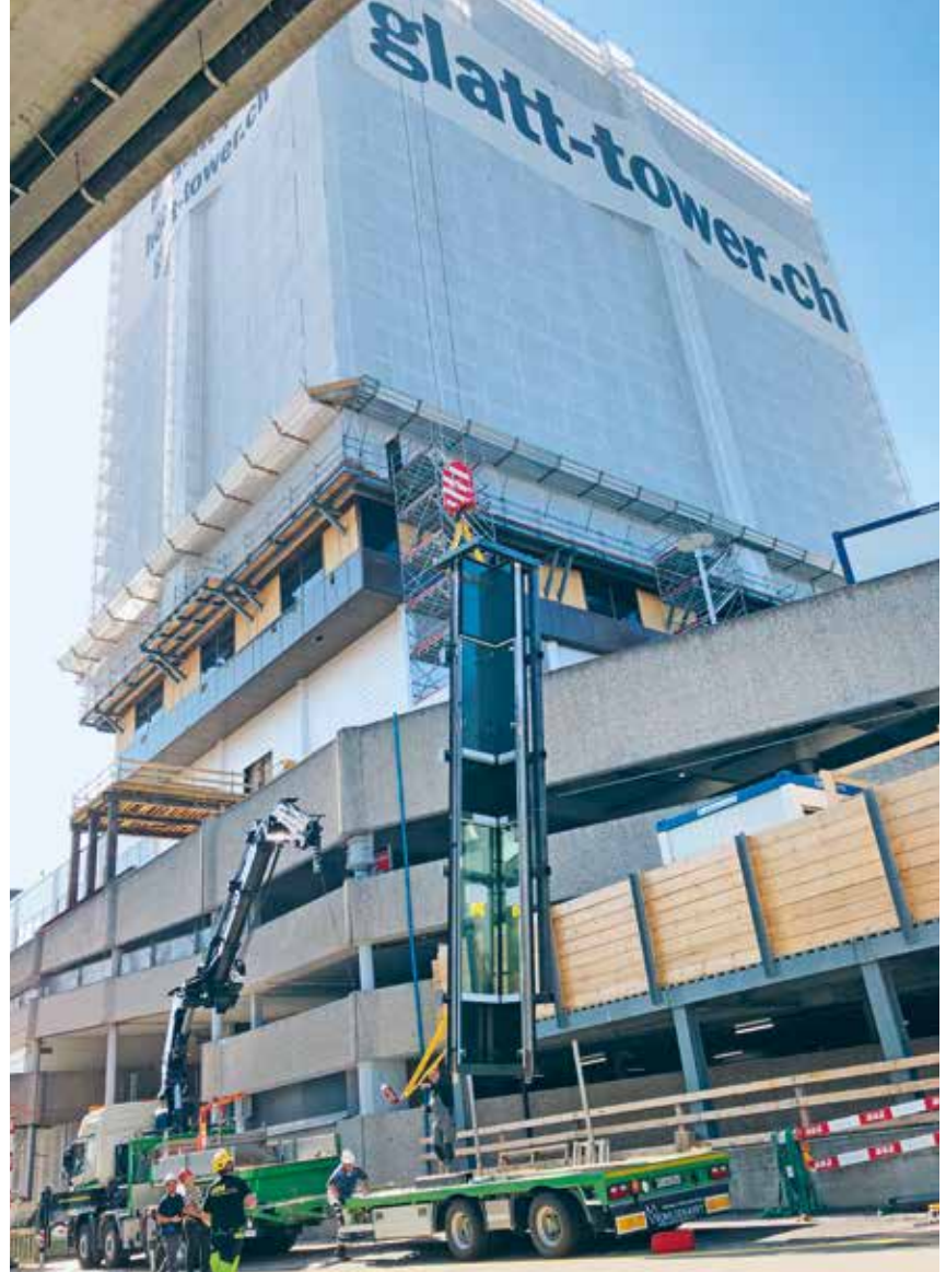
Ein 9 m hohes, verglastes Eckelement wird an seinen Zielpunkt gehievt. Levage et mise en place d'un élément d'angle de 9 m de haut.
