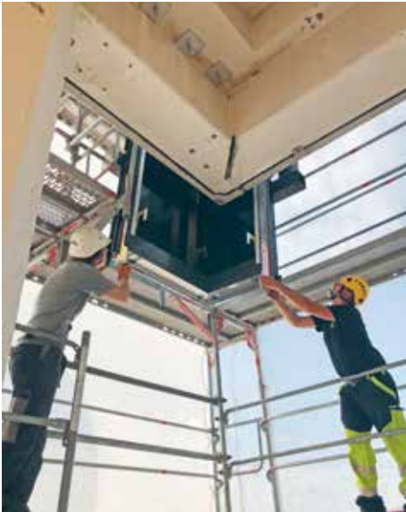
Die Demontagen und die Neumontagen erfolgten immer geschossweise, von oben nach unten. Les démontages et remontages ont toujours été effectués par étage, de haut en bas.
